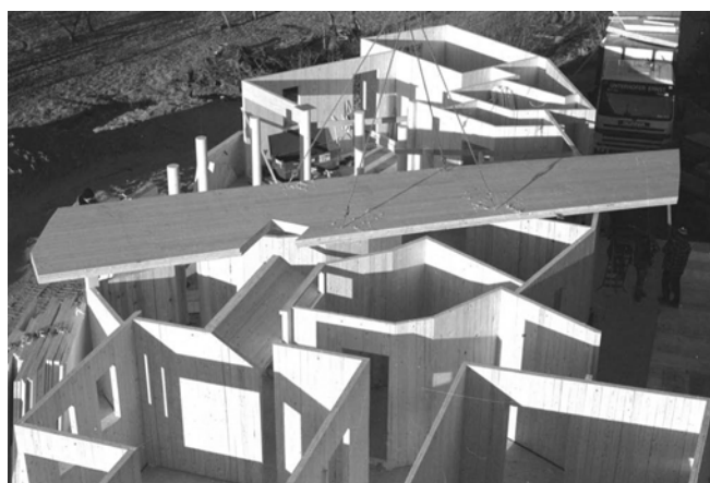
Slika 2. CLT konstrukcija [2] Figure 2. CLT construction [2]
